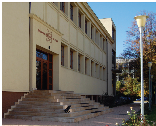
Fig. 2 Clădirea Bibliotecii Naționale de Fizică, 2009
